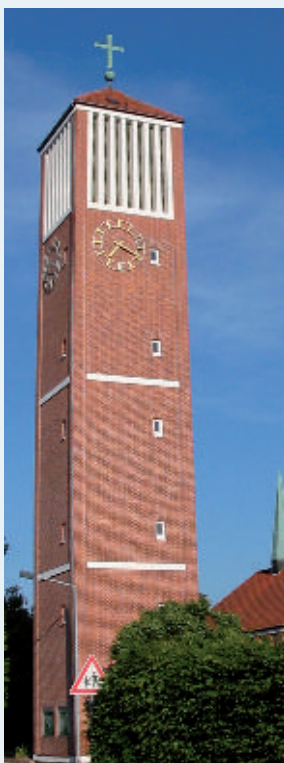
Der Kirchturm nach der Renovierung 2004
