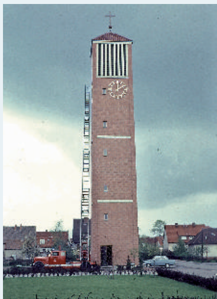
Mai 1965: Die Kirchturmuhre – ein Geschenk der ehem. selbstständigen Gemeinde Westercelle – wird installiert.
