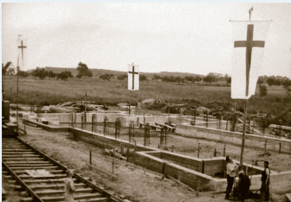
1961: Die Fundamente der Christuskirche sind erbaut worden. Der Blick geht ostwärts. Im Hintergrund sind die Bäume der Bennebsteler Straße zu erkennen.
